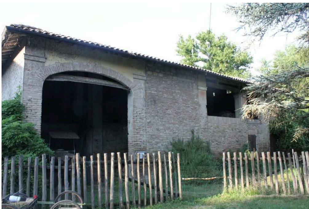
Documentazione Fotografica – Mappale 162 – Vista lato sud
