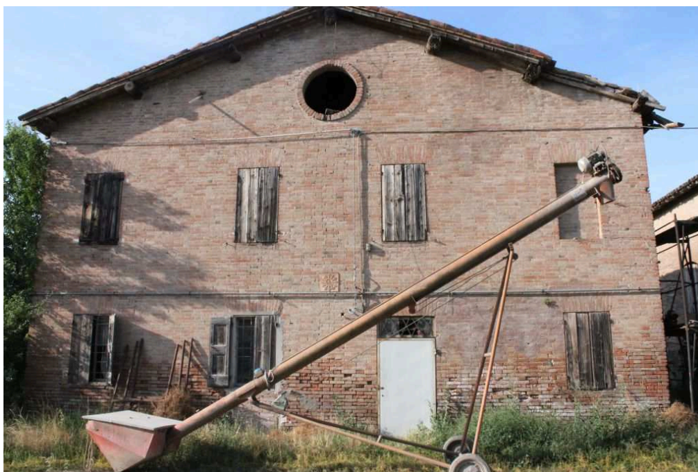
Documentazione Fotografica – Mappale 45 – Casa rurale - Vista lato sud-ovest
