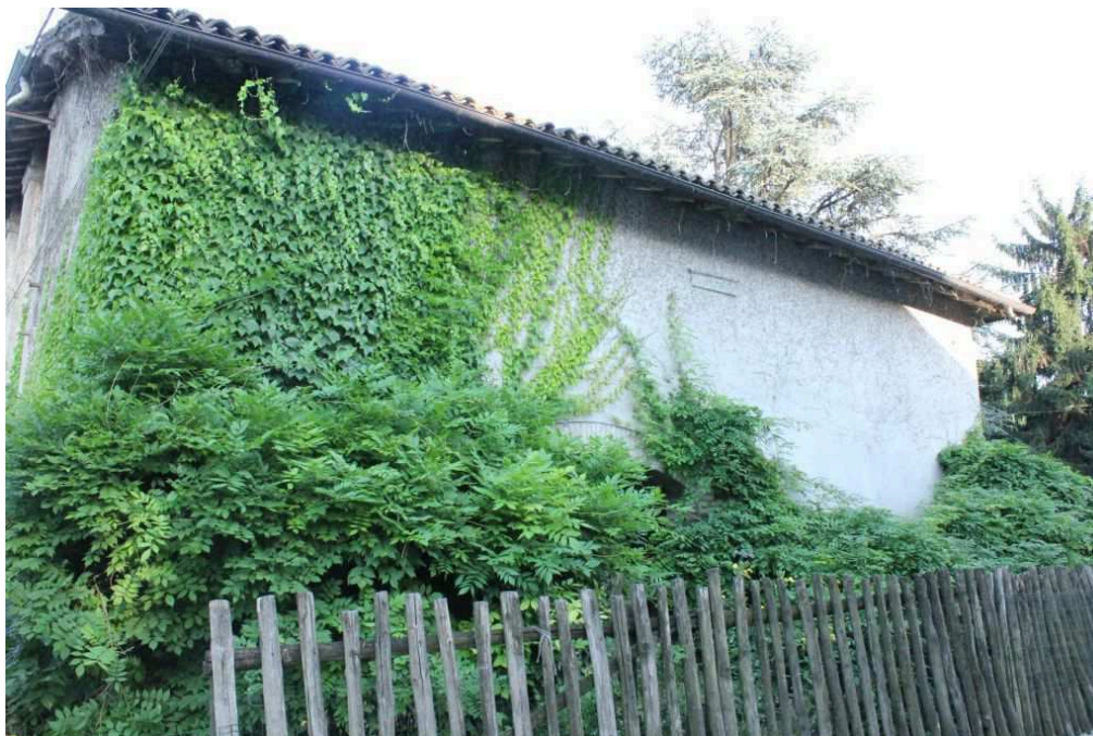
Documentazione Fotografica – Mappale 162 – Vista lato ovest
