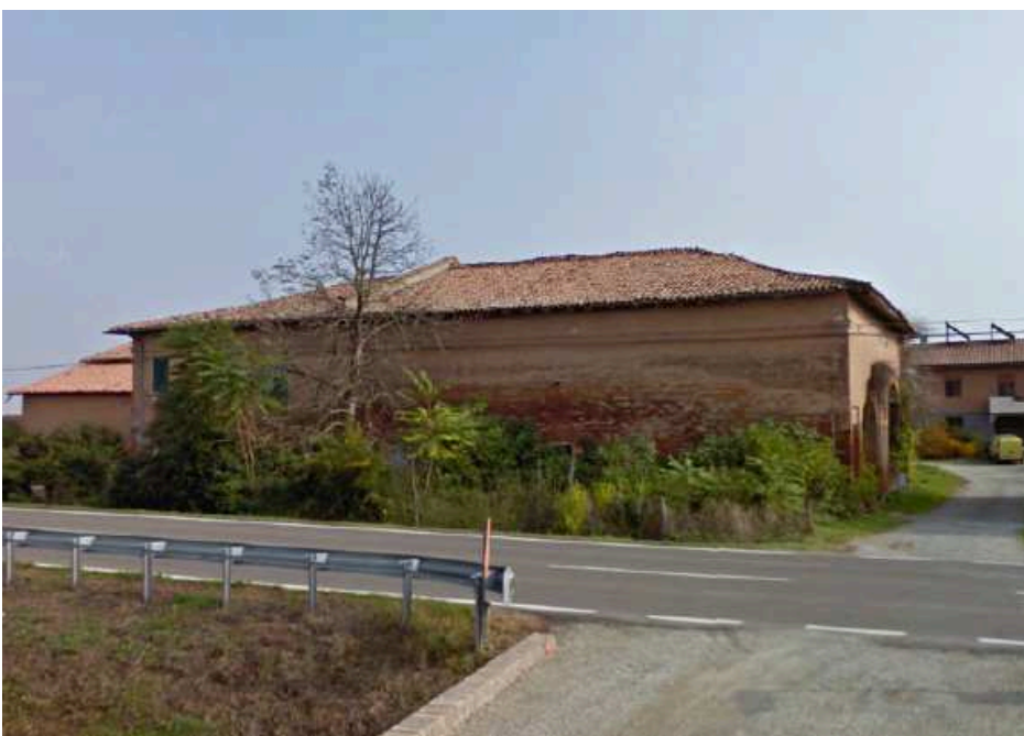
Documentazione Fotografica – Mappale 157 – Stalla/Fienile - Vista lato ovest
