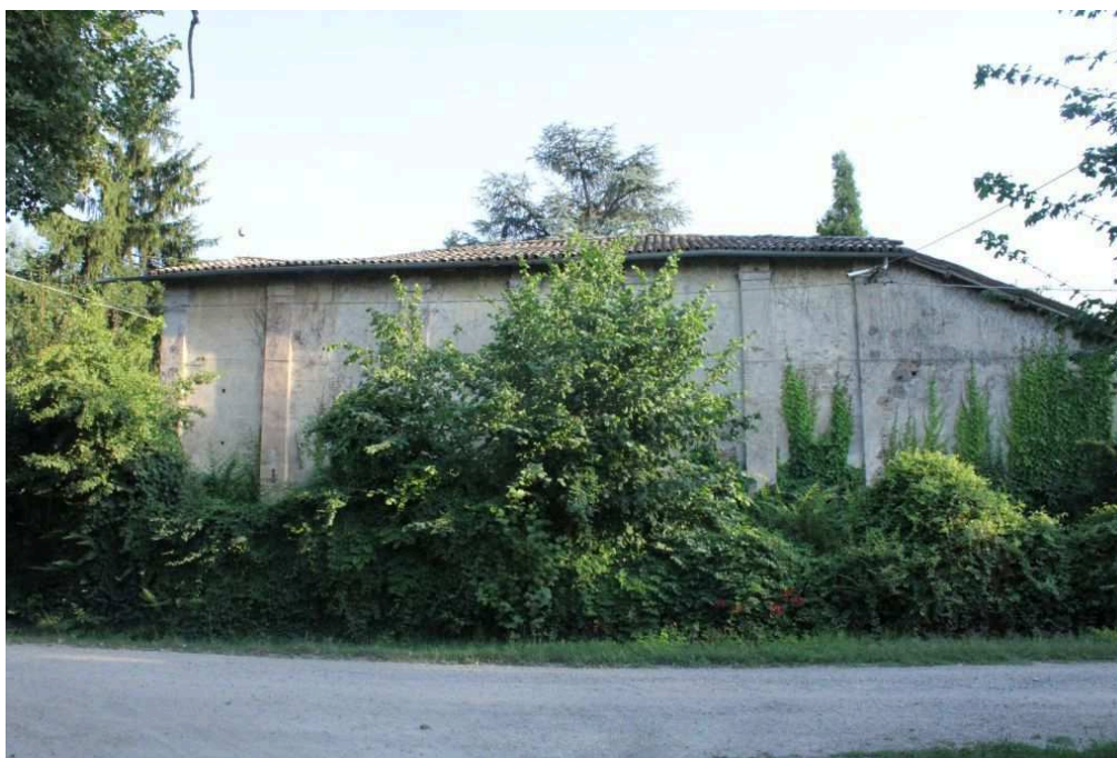
Documentazione Fotografica – Mappale 162 – Vista lato nord
