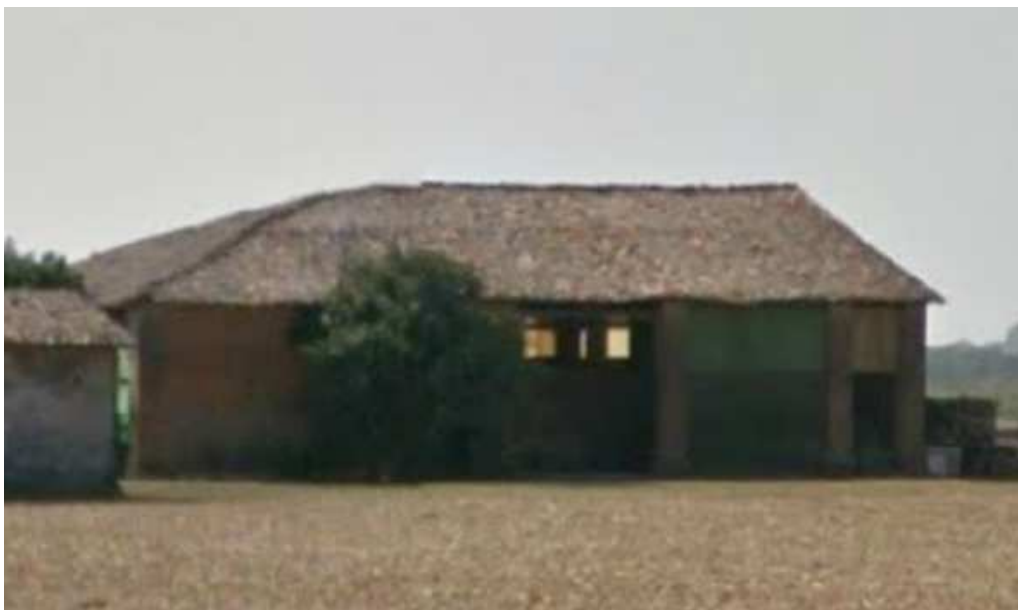
Documentazione Fotografica – Mappale 67 – Stalla/Fienile - Vista lato nord-est
