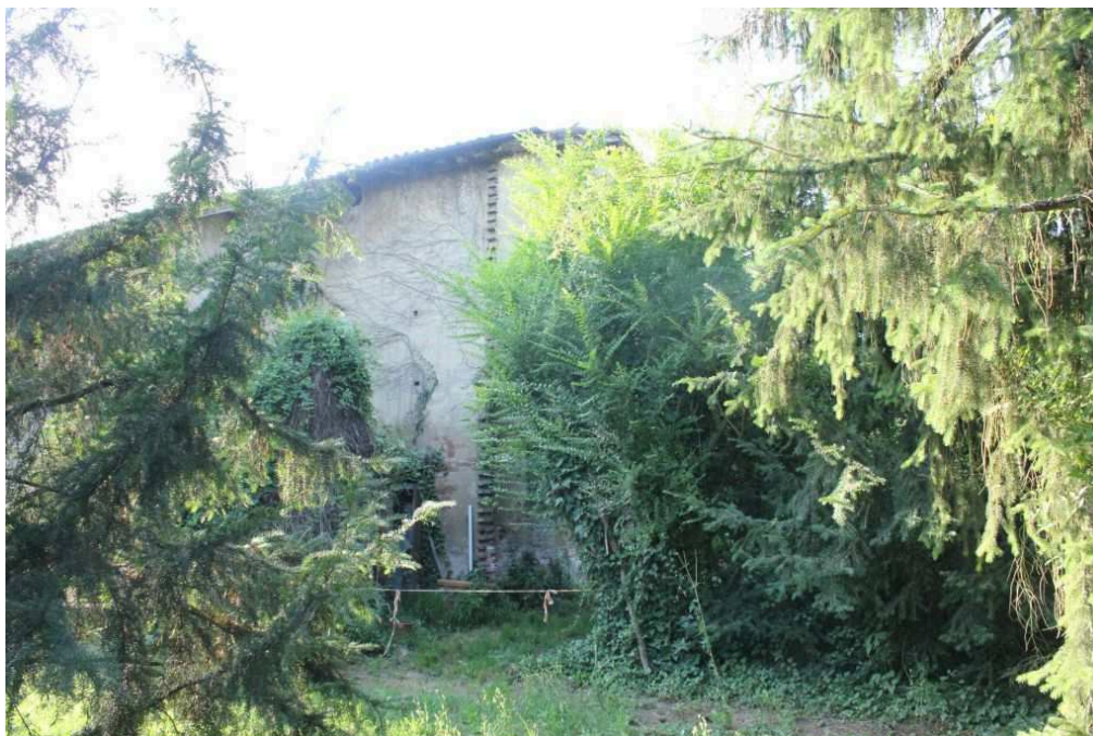
Documentazione Fotografica – Mappale 162 – Vista lato est
