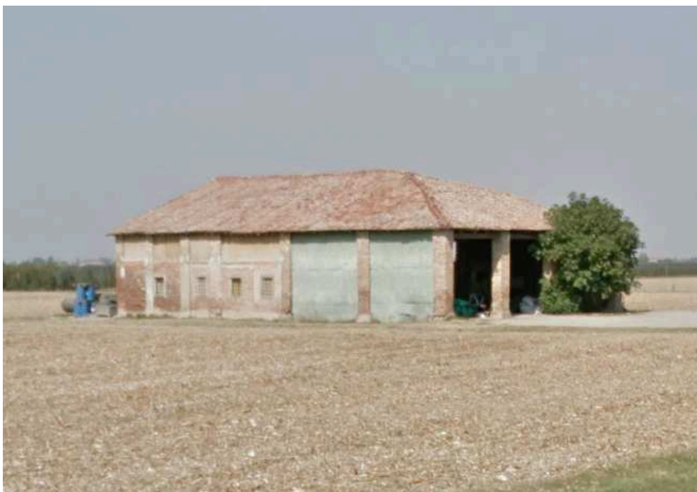
Documentazione Fotografica – Mappale 67 – Stalla/Fienile - Vista lato sud
