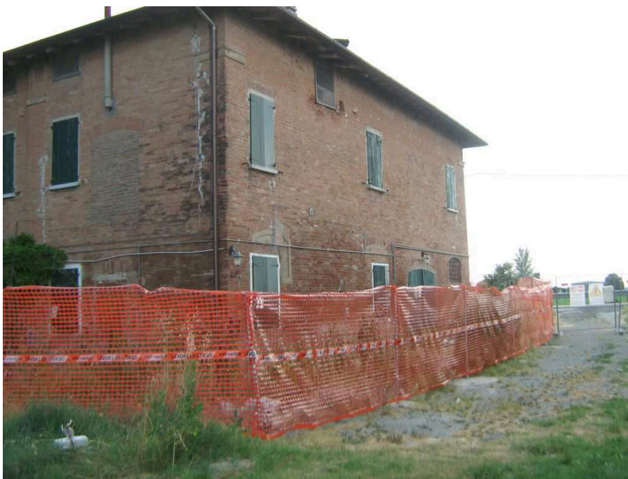
Documentazione Fotografica – Mappale 23 – Abitazione rurale - Vista lato nord-est
