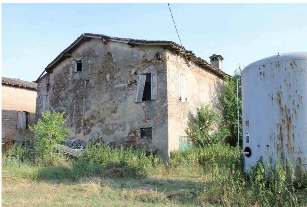
Documentazione Fotografica – Mappale 45 – Casa rurale - Vista lato nord
