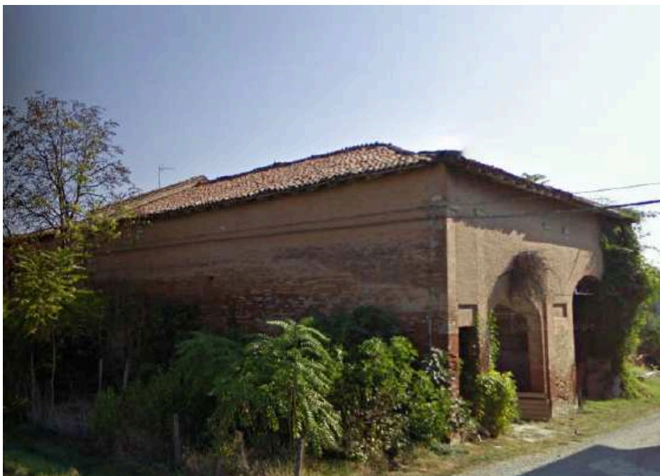
Documentazione Fotografica – Mappale 157 – Stalla/Fienile - Vista lato sud-ovest
